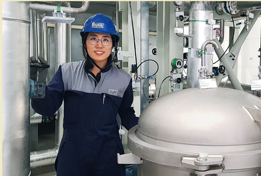
Ob Technik oder Kultur: Mi Hyang Shin stürzte sich ins Abenteuer und übernahm die Baustellenleitung in Marokko.
